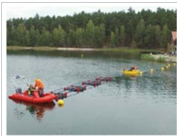
Sænkning af sø-varme elementer HURAKAN.
